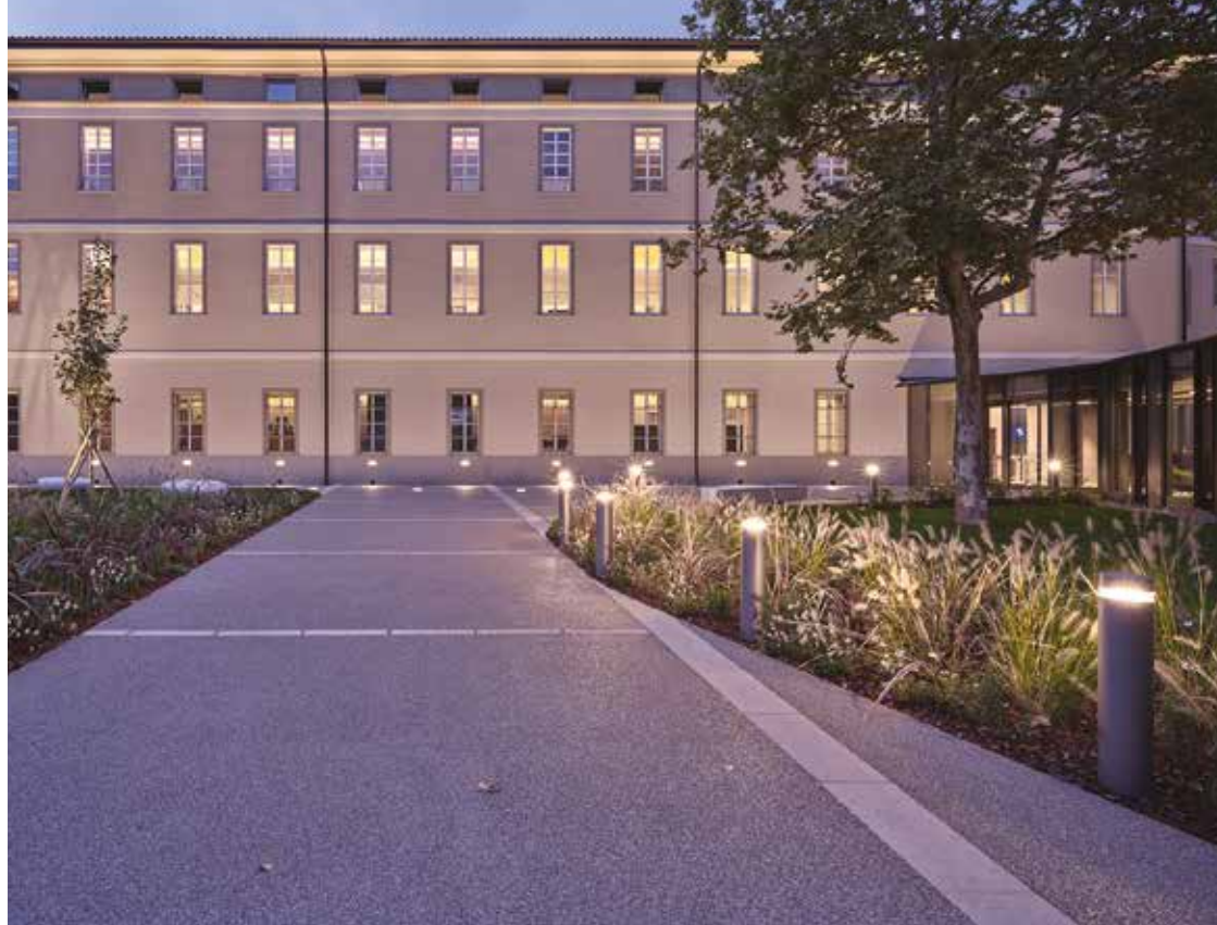
La nuova sede Cogefa nasce dalla riqualificazione dell'ex Istituto del Buon Pastore, storico complesso fondato nel 1843 da Re Carlo Alberto come istituto di correzione femminile e definitivamente dismesso nel 1977
